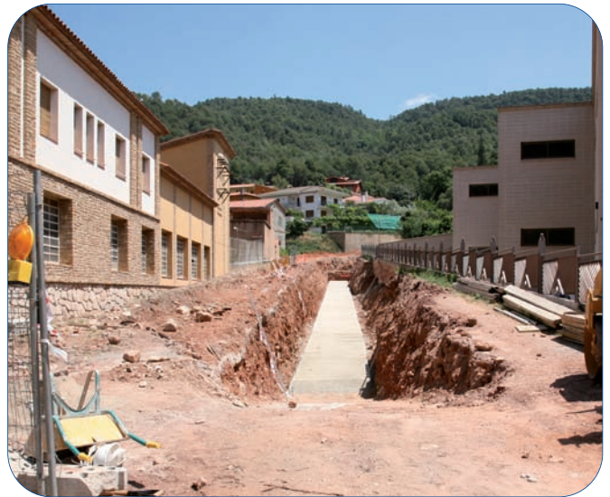
Tram d'obres del carrer Enamorats
